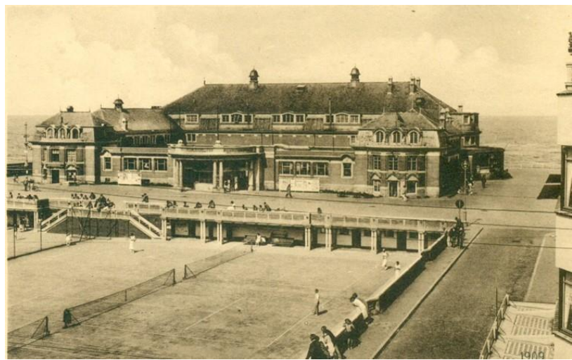
Tweede Casino Kursaal van Middelkerke - architect Géorges Hobé (i.s.m. Albert Van huffel). Postkaart collectie Marc Dubois
